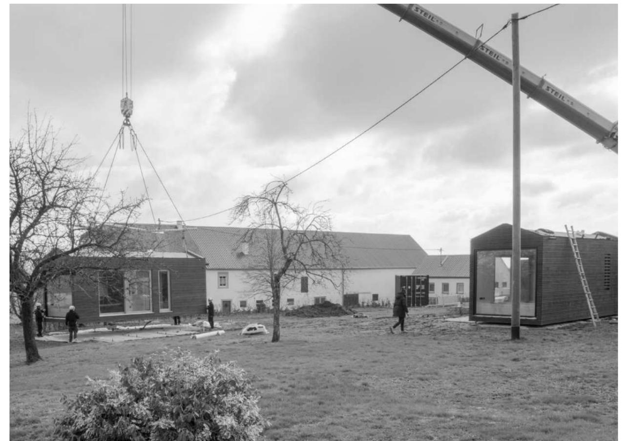
Das Grundmodul unserer Minimalhäuser besteht aus der Holzrahmenkonstruktion mit vorgefertigten Wandmodulen und eingeblassener Zellulosedämmung, der langlebigen Fassade, den Holzfenstern, sowie den Innenwänden mit Türen und dem Bodenbelag. Ergänzt wird die Grundausstattung durch Elektronik, Heizung, Einbauleuchten, ein Tageslichtbad mit Dusche, Waschbecken und WC, sowie den Küchenanschlüssen.
